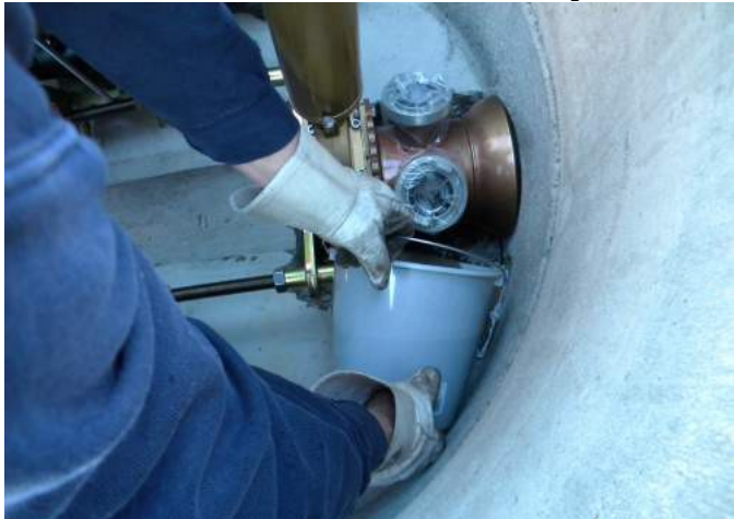
5. Vergießen des Bypass-Schieber mit schnell aus- härtendem Beton ist generell möglich.
