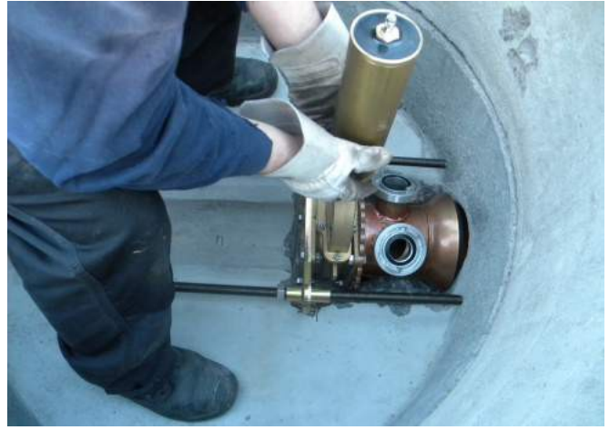
2. Vormontierten Bypass-Schieber inkl. der Spann- stangen fluchtgerecht in die Aussparung stellen
