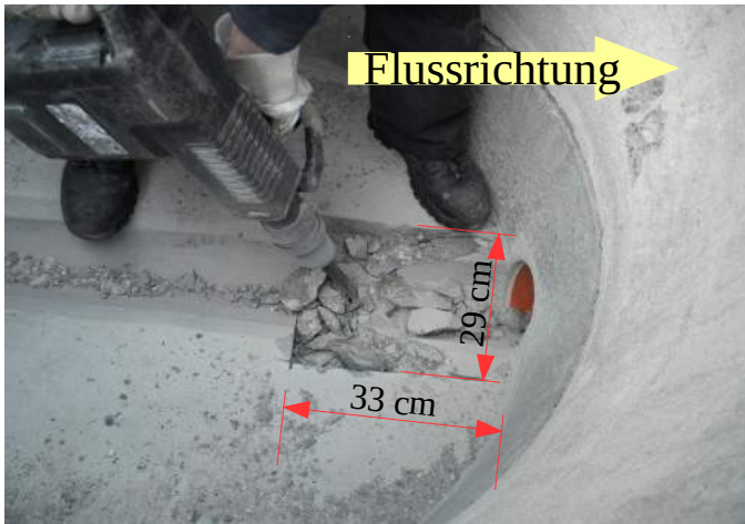
1. Ausbrechen des Oberbetons auf der Auslaufseite des Schachtgerinnes ca. L33 x B29 x T12cm
