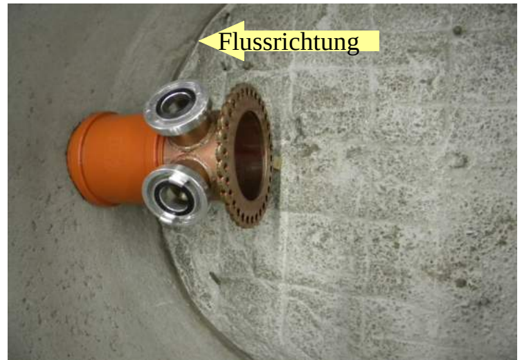
Der Druckabgangskopf Spitzende DN150 ist auf der Abflusseite zum Hauptkanal mittels KG-Doppelmuffe vormontiert.
