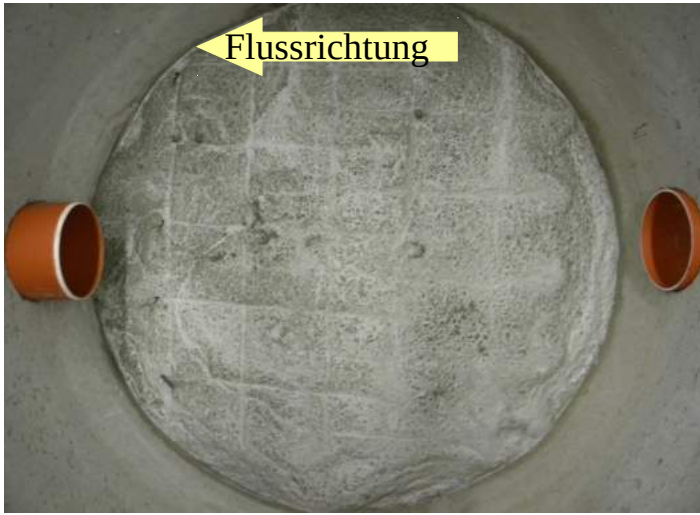
Die Schachtringe sind gesetzt, der Untergrund ist betoniert.
