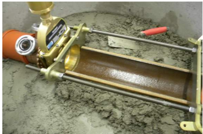
Eine Halbschale aus Steinzeug DN150 wird auf dem Untergrund betoniert, die Oberfläche glatt verstrichen.
