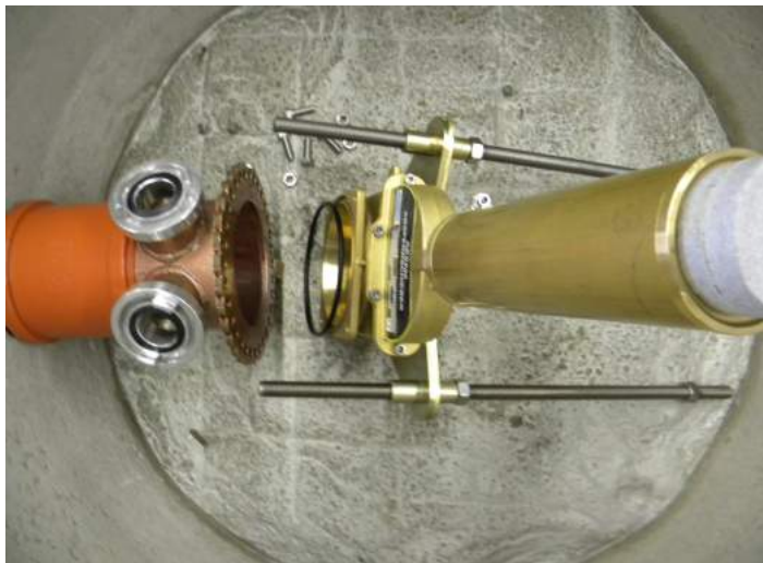
Der Absperrschieber wird mit 4 Schrauben am Druckabgangskopf befestigt, der Einspannrahmen über die Spannmuttern fixiert.
