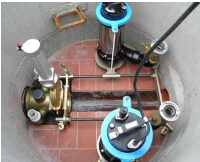
Nach der Installation der Fäkalienpumpen werden diese ...
