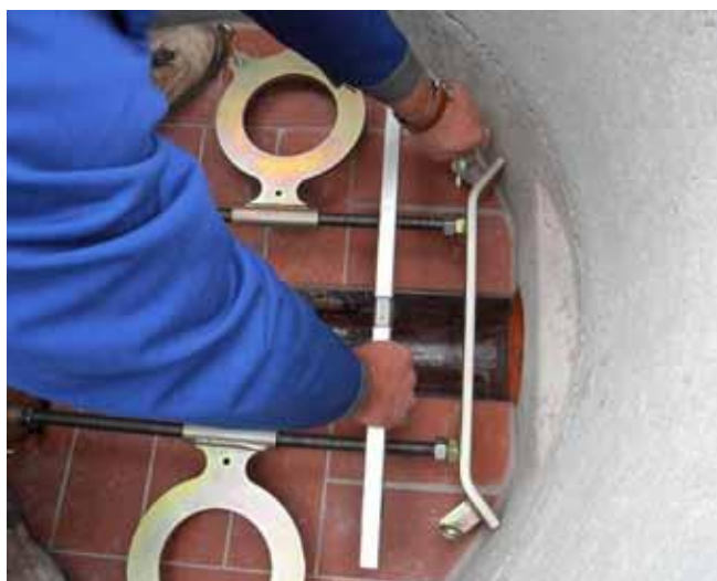
Mit der Höhenverstellung kann der Rahmen ausgerichtet werden.
