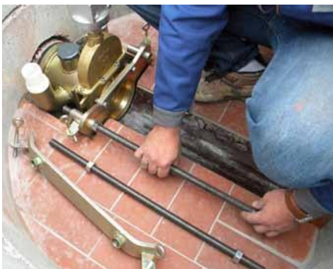
Die Absperreinheit und der Einspannrahmen können jetzt montiert werden.
