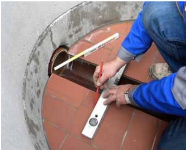
Anzeichnen der Aussparung für die Absperreinheit auf der Auslaufseite des Schachtes.
